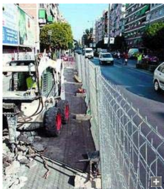
Los trabajos en el Camino de Ronda comenzaron el pasado de verano.
