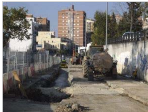
OBRA. En la carretera de Alfacar se terminan las acometidas de abastecimientos de aguas. /J. E. G.
